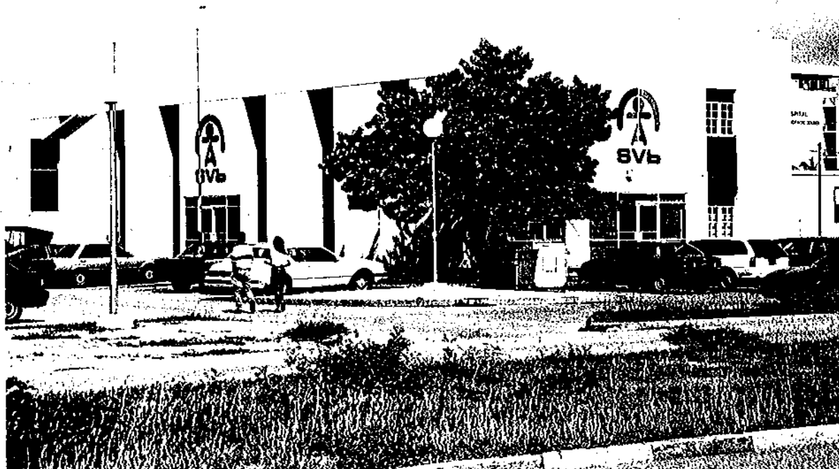
Afb. 2: Kantoorgebouw Sociale Verzekeringsbank
